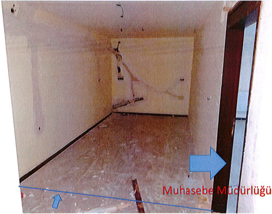
Sürgülü kapı yapılacak kısım
